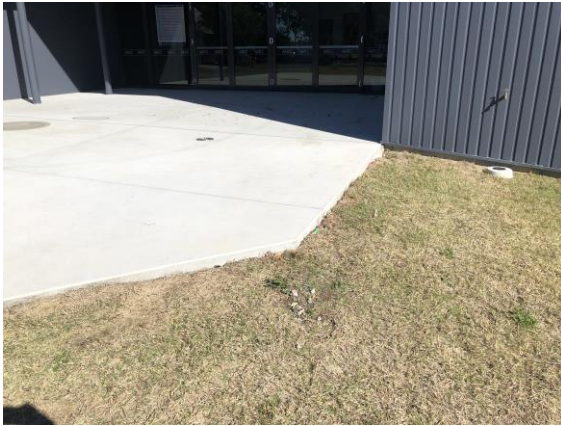
Entry paving west edge
